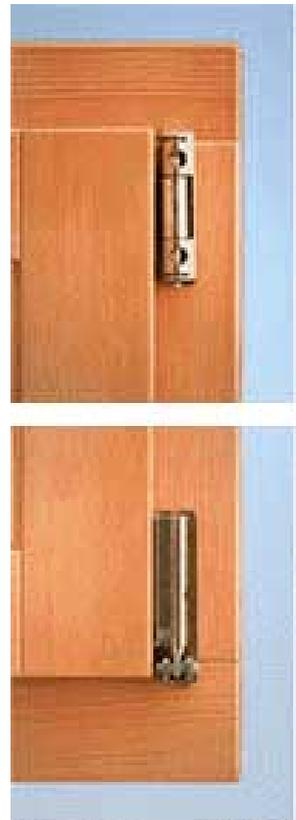
Ein hohes Maß an Sicherheit bietet bereits die **Basisversion** durch den Pilzzapfen an der Flügelunterkante, der in das Kipplager greift. Siehe Info Widerstandsklasse 1, Schließzapfen P
