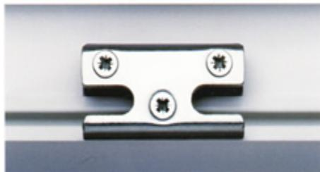
**Die Widerstandsklasse 2** der mechanischen Absicherung baut auf der Klasse 1 auf. Zusätzlich verstärken spezielle Sicherheitsbauteile mit hintergreifenden Pilzzapfen rund um den Flügel die Verbindung zwischen Fensterflügel und Fensterrahmen. Das heisst: Beschlag und Fensterrahmen halten stärkeren Belastungen stand.
